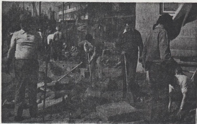
Kładzenie chodnika na ul. Matorolnych
