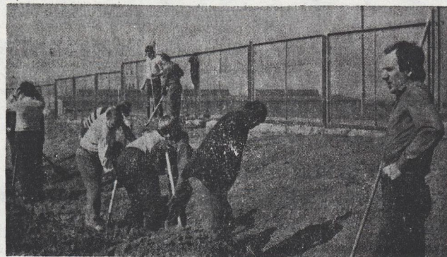
Profilowanie skarpy na budowie Fabryki Domów
