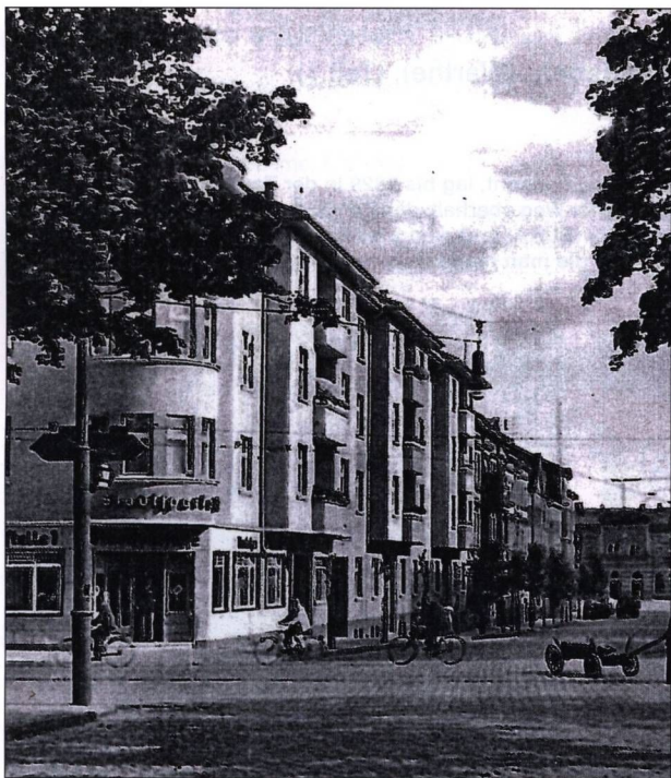
Die Filiale 1 der Stadtsparkasse in der Bahnhofstraße. Die Kreissparkasse hatte in der Küstriner Straße neben der Loge eine weitere Filiale, eine Abbildung hiervon ist nicht bekannt. (SBF PK21002)
