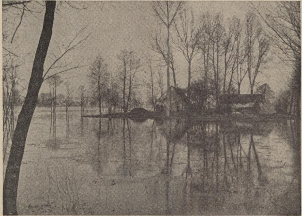
Bauernhof im Bruch von den Hochwasserfluten eingeschlossen.
