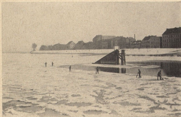
Die Warthe in Landsberg – Das Eis vor der Brücke wird aufgesägt, um die (damals hölzerne) Notbrücke beim Eisabgang nicht zu gefährden.
