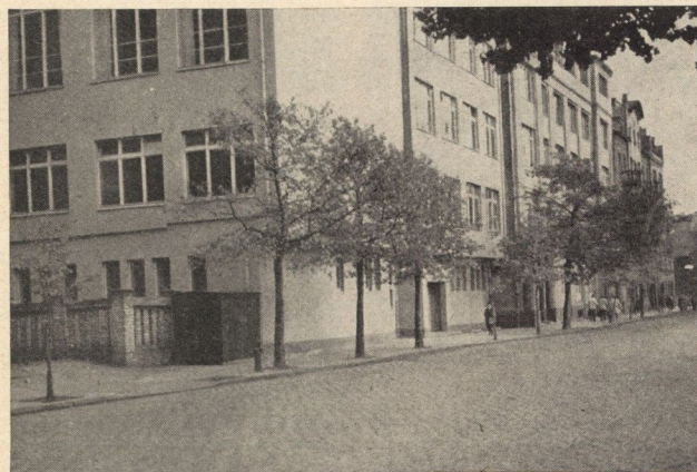
Neben dem Wohlfahrtshaus in der Moltkestraße steht jetzt dieses neue Schulhaus anstelle der ausgebrannten Turnhalle des Männer-Turnvereins.
