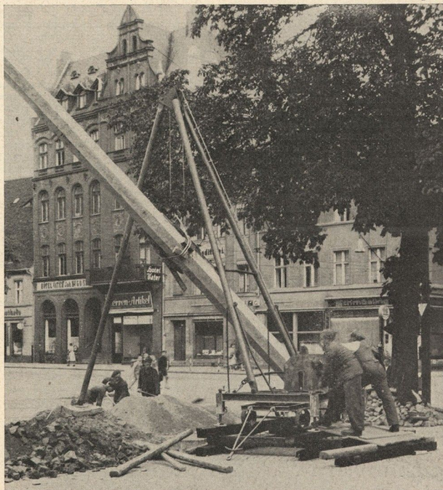
Aufstellung eines Betonmastes für den Fahrdrat des Omnibusbetriebes Bild oben: Richtstraße und Markt mit den ersten Straßenbahnwagen
