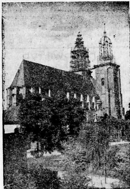
Katedra gnieźnieńska na górze Lecha w odbudowie
