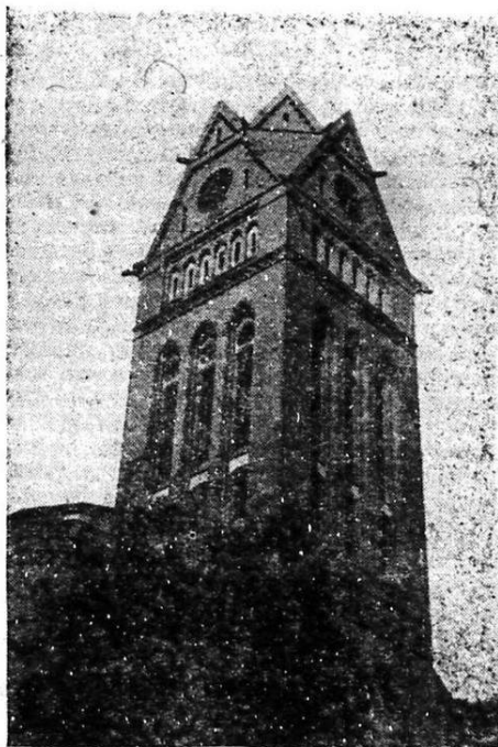
Odremonutowana wieża kościoła akademie- kiego w Szczecinie.
