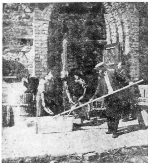
Sulechowanie przy remoncie swego kościoła
