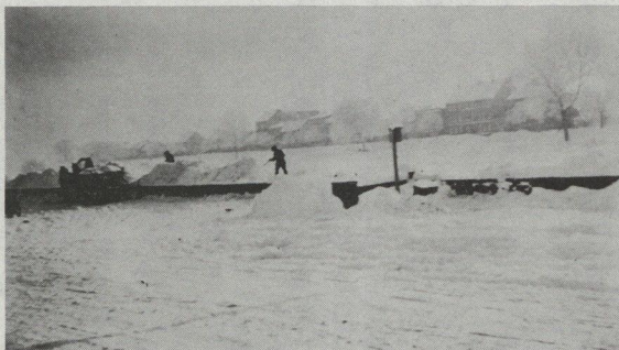
Winter 1940 in Landsberg! – Die Schneemassen aus der Stadt werden am Bollwerk in die Warthe befördert. . . erinnern Sie sich noch?
