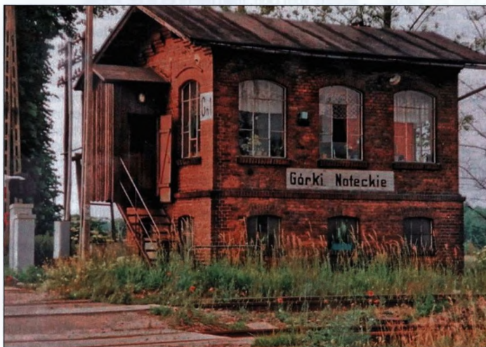
Das Schrankenwärterhaus am Bahnübergang bei Gurkow.
