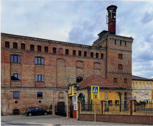
Das Hauptgebäude der ehemaligen Stern-Brauerei.
