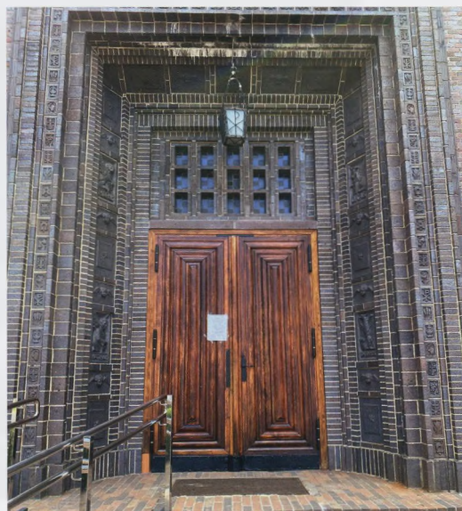
Die Einfassung der Kirchentür wurde mit zahlreichen Schmuckklinkern aufwändig gestaltet. Bild: SL
