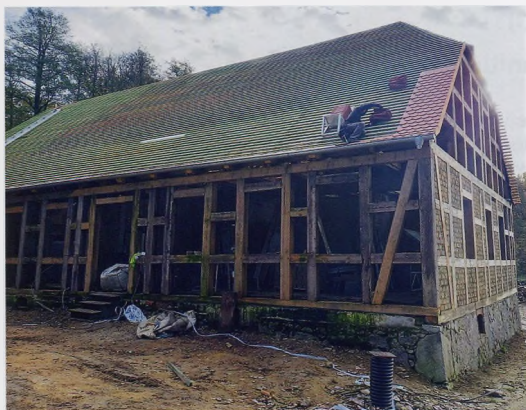
Das Dach wird mit Biberschwanzziegeln eingedeckt.
