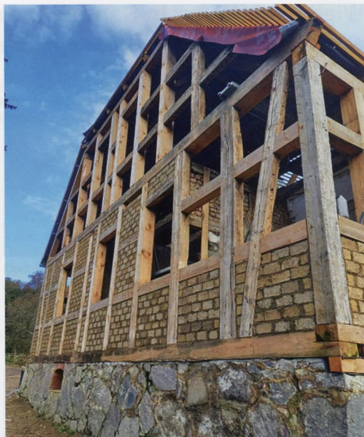
Nachdem die Holzbalken erneuert wurden, werden nun die Felder des Fachwerks ausgemauert.
