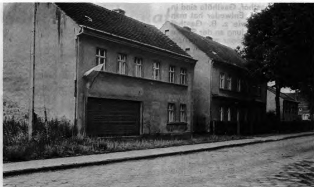
Die ehemalige Bäckerei Rehfeld in der Bahnhofstraße in Döllensradung; daneben die Tischlerei Müller.
