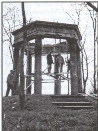
Początek remontu pawilonu
