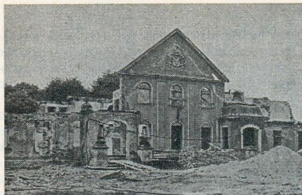
Pałac w Bobowicku przed i po remoncie
