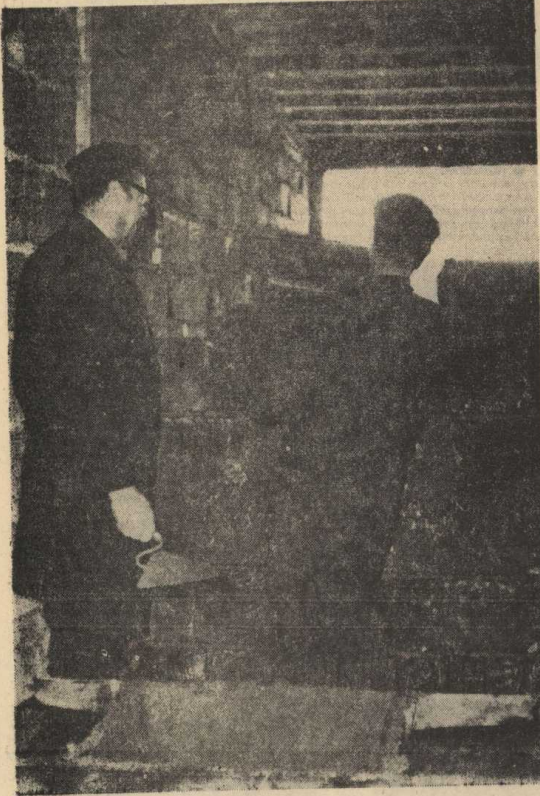
Prace przy budowie garaży
