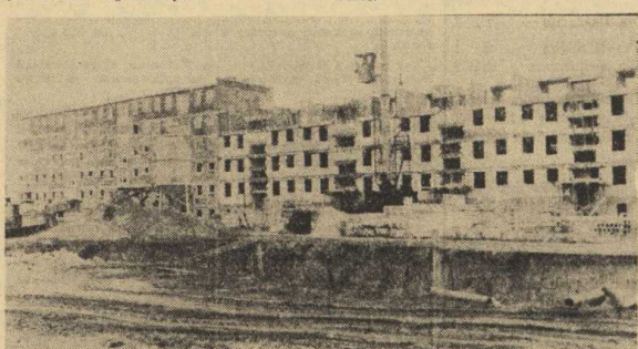
Dobiega końca budowa nowego bloku mieszkalnego przy ul. Boh. Stalingradzkiej
