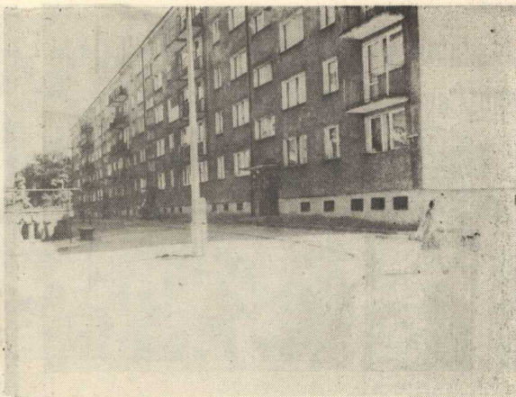
Bloki mieszkalne przy ul. Dworcowej bez zieleni
