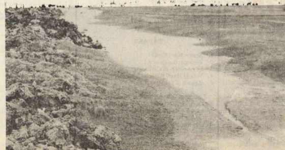
Przystąpiono do budowy czwartego osadnika płaskiego, gromadzi się też materiały na budowę nowego kolektora ścieków chemicznych. Na zdjęciu: Jeden z czynnych osadników płaskich.
