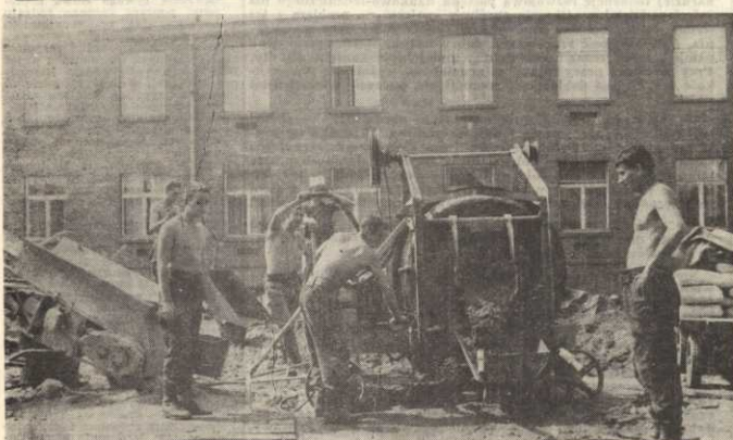
Żołnierze WP pomagają przy rozbudowie stołówki zakładowej
