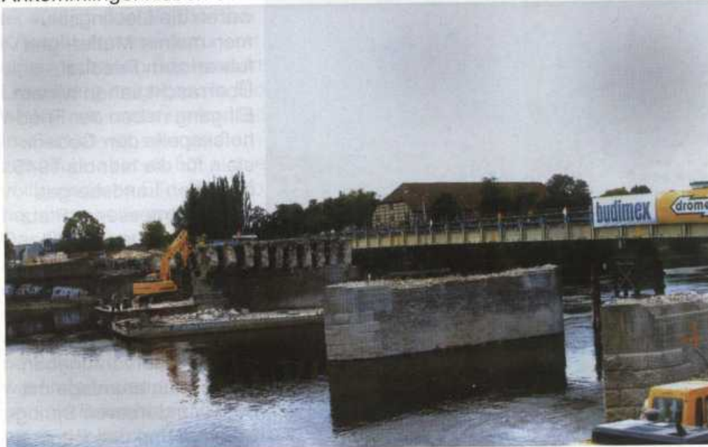
Abriss und Neubau der Warthebrücke 2006
