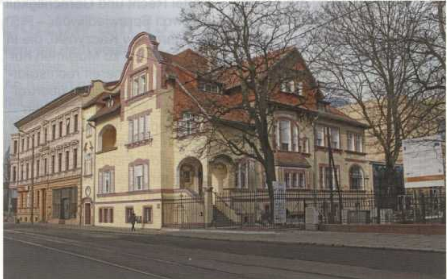
Die ehemalige Villa Lehmann, renoviert in der Sikorskiego 107
