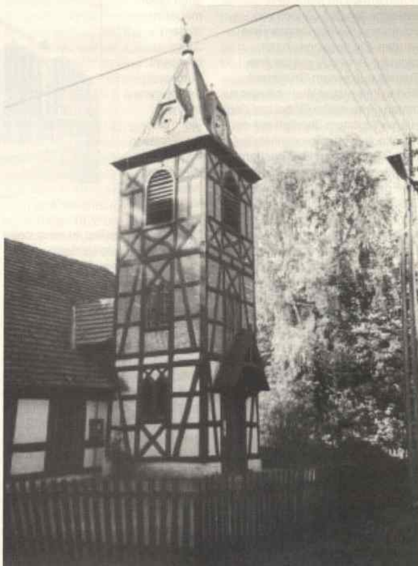
Das Verwaltungsgebäude wurde zur Dorfkirche
