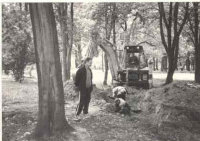
Exhumierungsarbeiten auf dem evangelischen Friedhof
