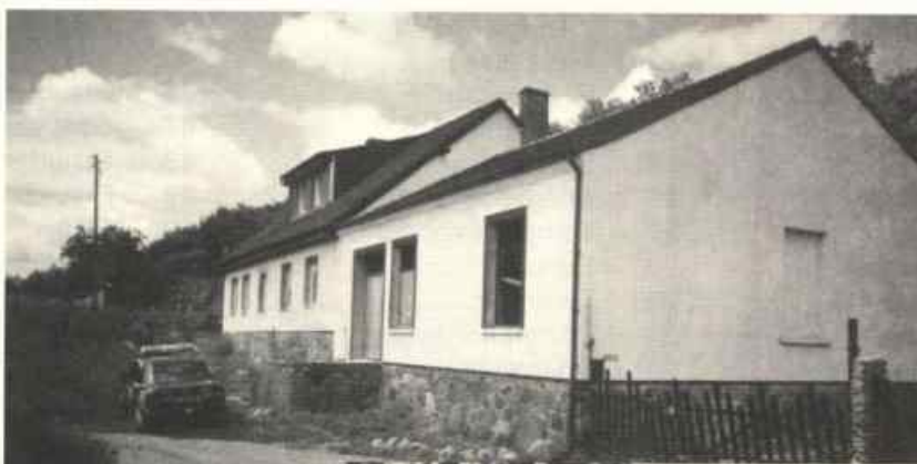
Das ehemalige kleine Gasthaus ist im Rohbau wiedererstanden, es soll demnächst mit Saal für Sport, Spiel und Restauration eröffnet werden.
