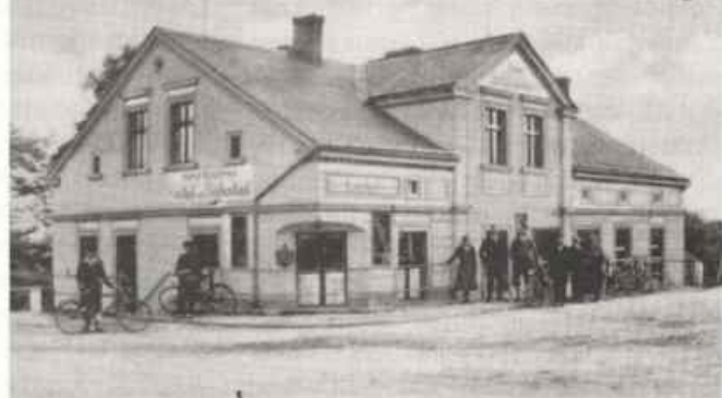
Gasthof zum Brückenkopf Herst Schönrock, Brückendorf a. Warthe - Telef.: Döllensradung 08
