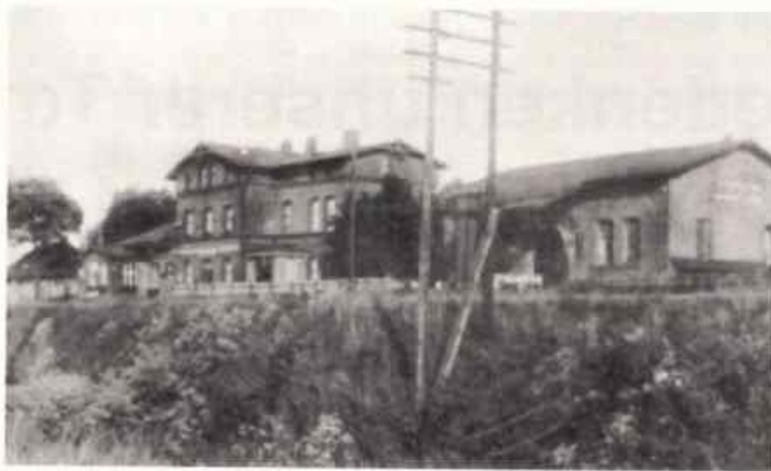
Bahnhof in Dühringshof
