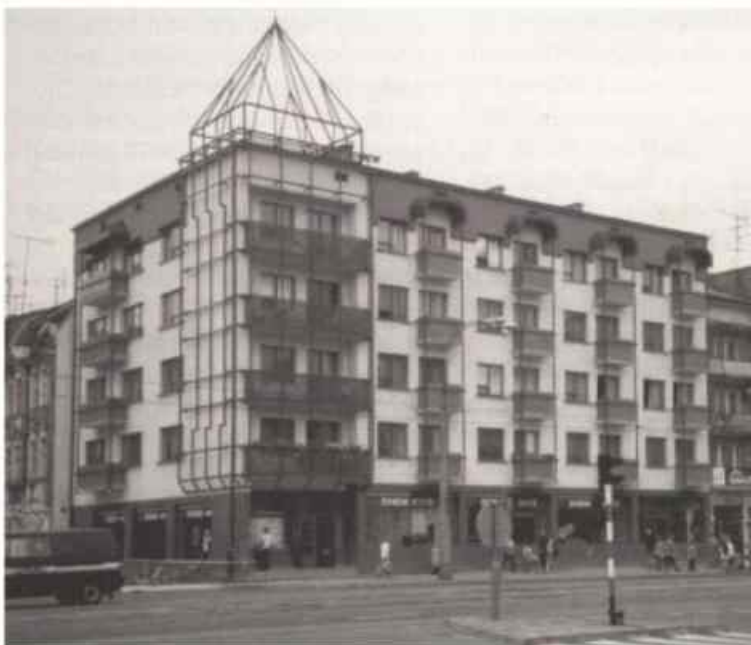
Neue Hausfassade Richtstraße/Poststraße
