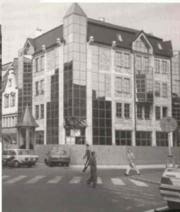
Neubau Ecke Wollstraße/Poststraße
