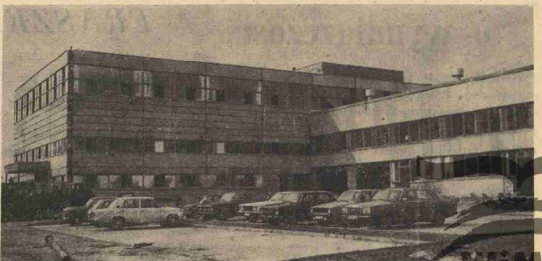
Zbliżyliśmy się do końca budowy Zakładów Przemysłu Odzieżowego „Komeks” w Słubicach
